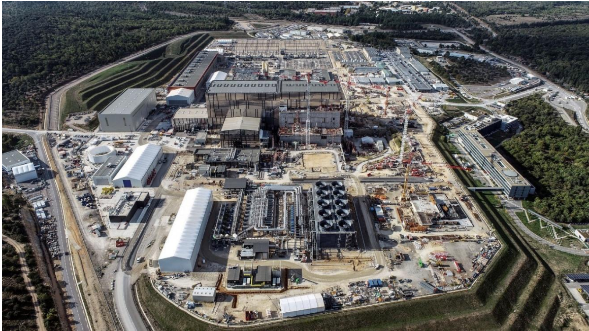
ITER complex ITER bouwen oktober 2021
